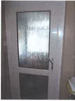
5. New porch Door
