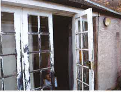
5. Rear patio door
