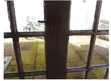
7. Rear Patio Door
