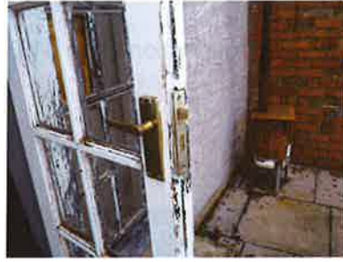
6. Rear Patio Door
