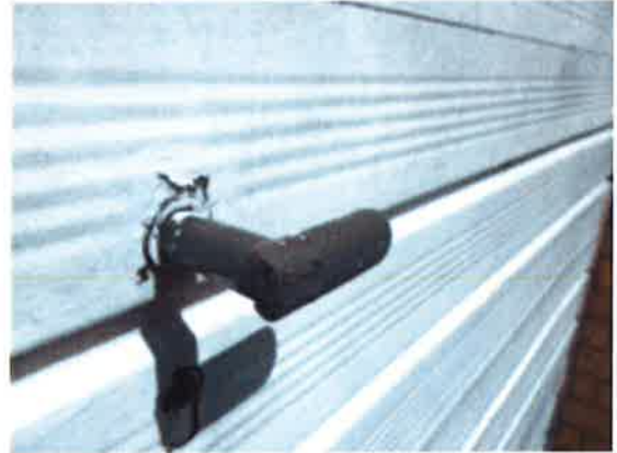
Garage - metal door broken handle
