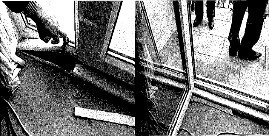
Patio Door 15 th April 2015
